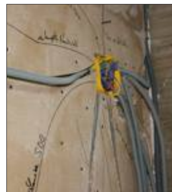
Les travaux d'installation électrique ont débuté il y a quelques jours.
