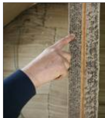
Pour isoler les murs intérieurs, une couche de 4 cm de carton ondulé est nécessaire.
